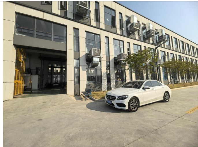
项目厂界南面-广西柳众智能科技有限公司
