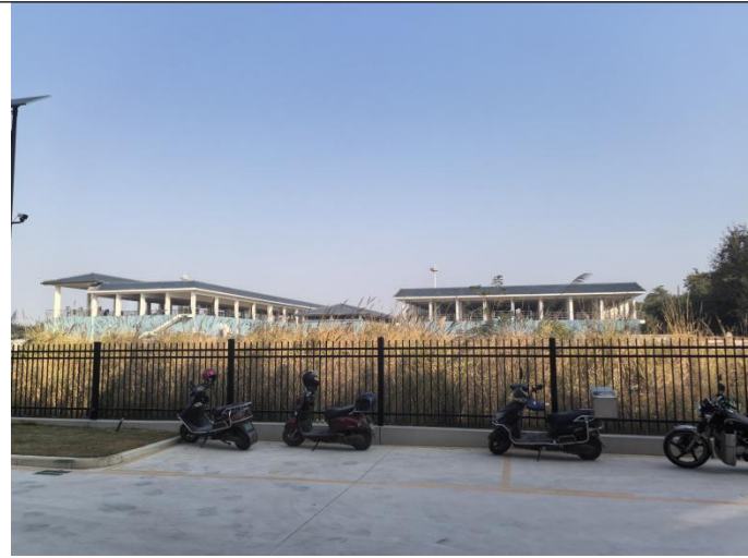
项目厂界北面-阳和污水处理厂
