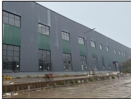
东面 广西博睿恩金属科技有限公司厂房
