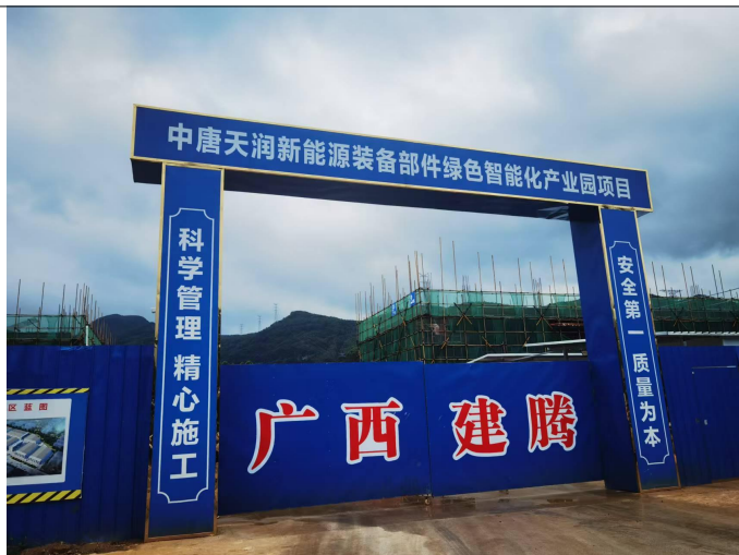
项目厂房现状
