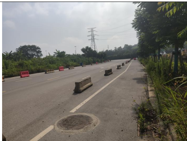
项目进场道路
