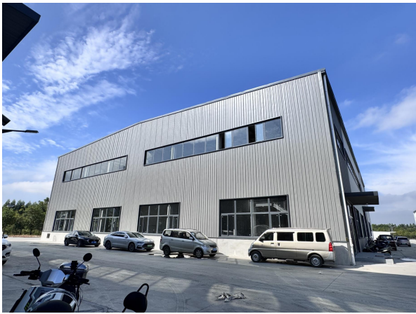
项目西面待入住厂房
