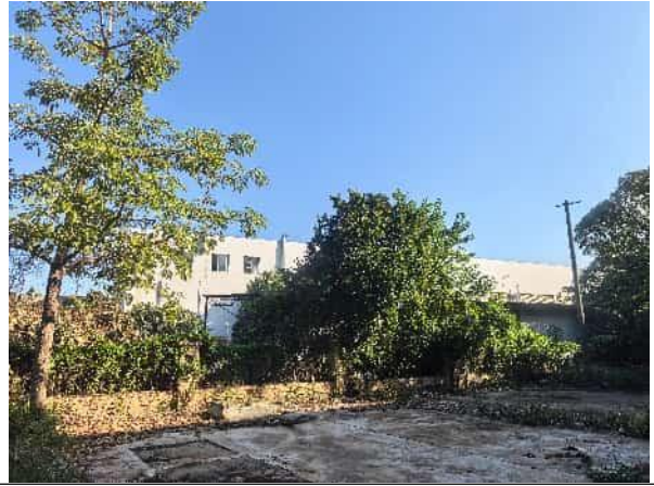
项目北面现状
