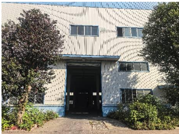
项目东面现状（闲置厂房）
