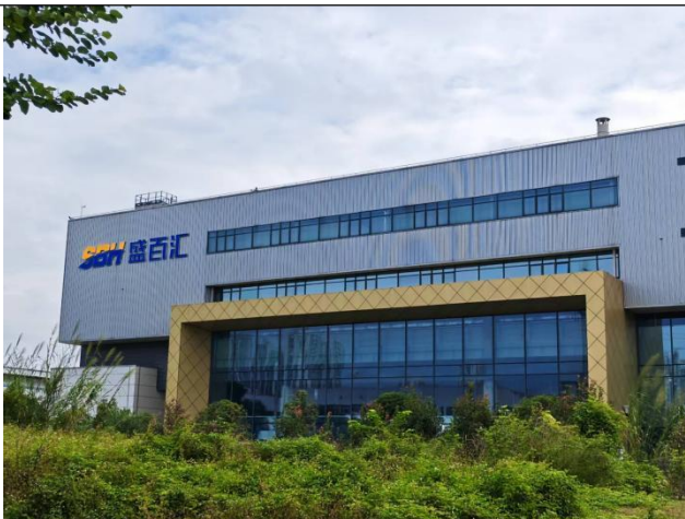
南侧广西盛百汇科技有限公司
